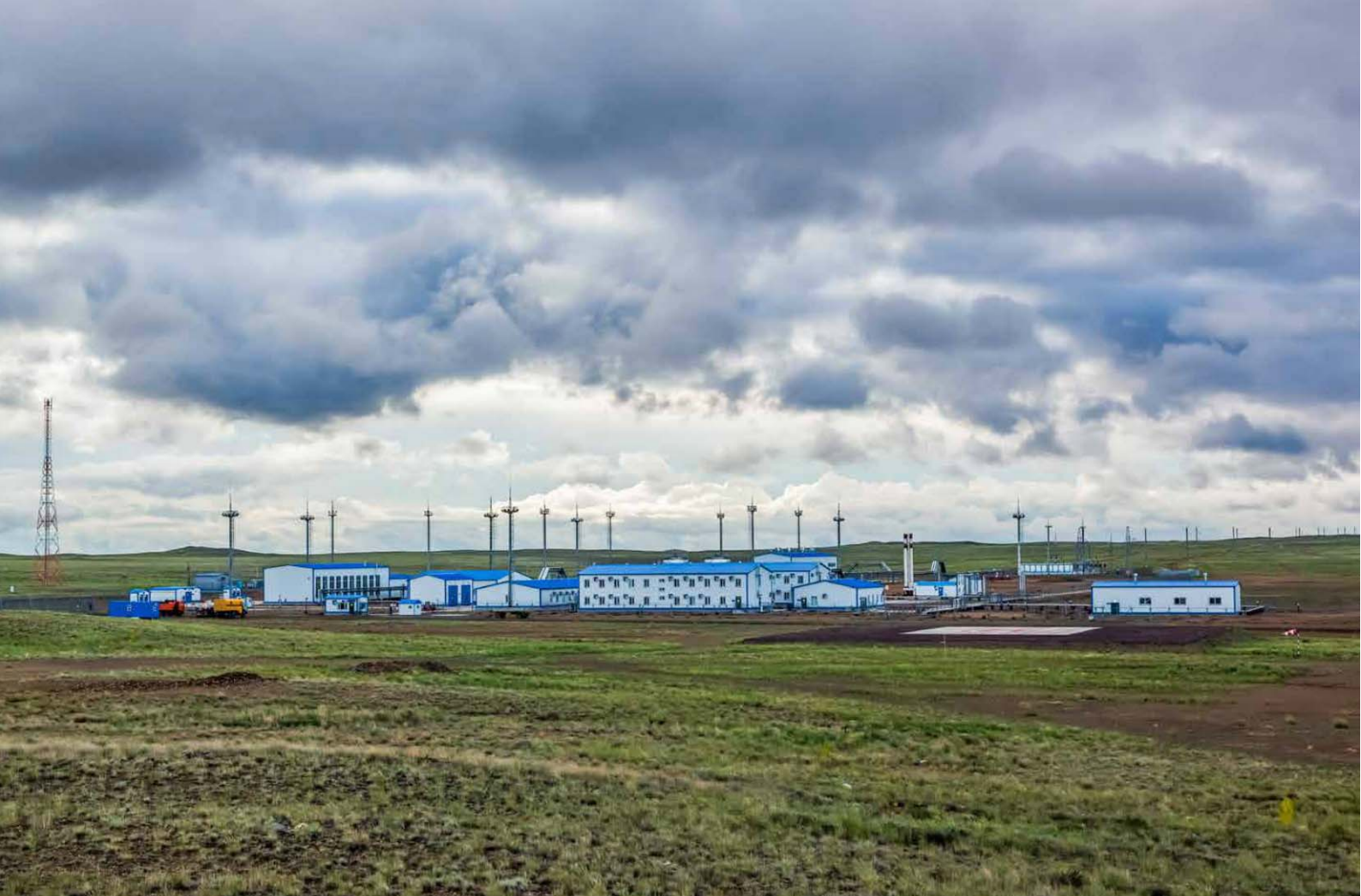
中哈原油管道10号泵站 摄影/尹志成
