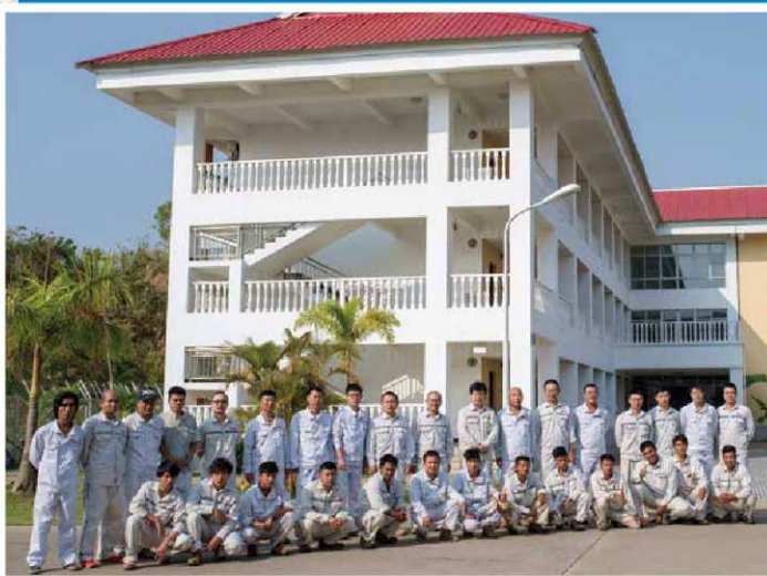
模范站队：中缅油气管道项目马德岛皎漂管理处新康丹泵站
