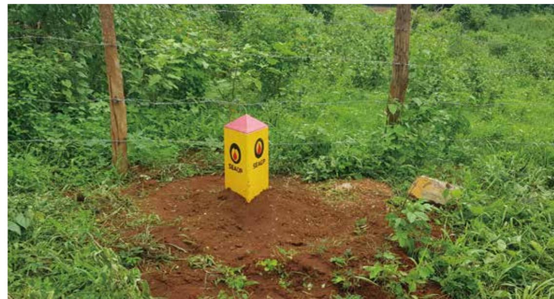
为确保木姐管理处辖区内“三桩”的完好，有效发挥其标示管道路由、保障管道权益、减少第三方施工破坏的作用，木姐管理处连续数年克服安保、社会依托差等困难，每年分别于汛前、汛后组织各级管道管理人员用徒步的方式对所辖区域“三桩”进行全面检查。木姐管理处并结历史记录，以及比照标准规范，检查“三桩”是否完好，桩体是否有丢失、移位、损坏，桩体表面是否出现掉漆导致标识内容不清等情况。同时，及时对丢失的和损坏的“三桩”进行补充、更换，对字迹不清的“三桩”进行重新刷漆。
